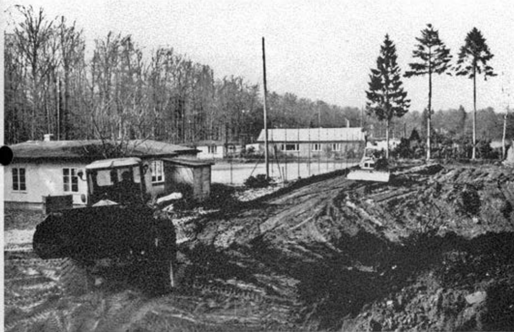
Erdarbeiten während der Erschaffung der beiden neuen Plätze an der Dusterlohe.
